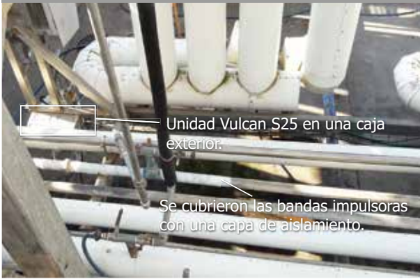
Se usa un equipo Vulcan S25 para tratar el depósito de agua caliente.
