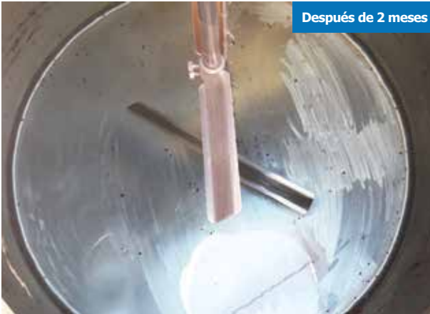
Grandes cantidades de cal por dentro y por fuera del depósito; era necesario limpiarlo cada dos semanas echándole ácidos.
