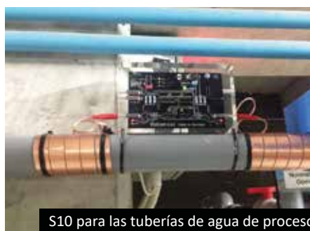
Bandas impulsoras recubiertas de aislamiento para tuberías
