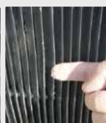
Rejillas de torres de refrigeración
