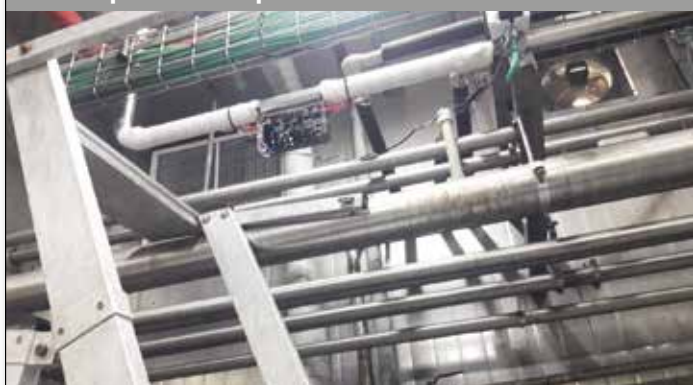
Se usa un equipo Vulcan S10 para tratar las máquinas de limpieza in situ.
