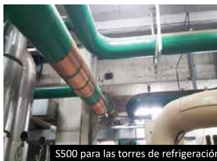
S10 para las tuberías de agua de proceso
